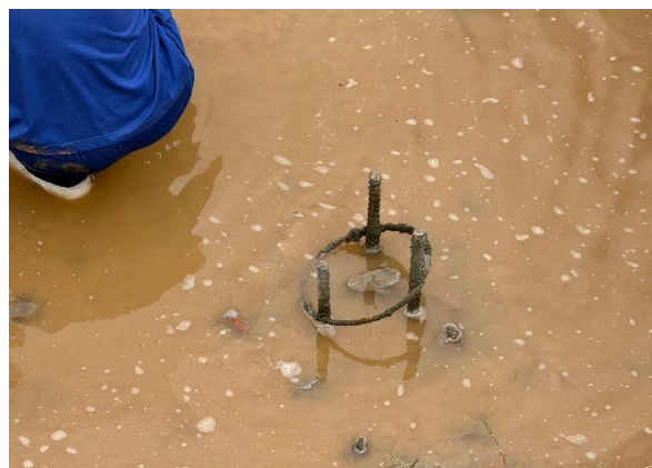
Foto 16: Execução de estaca escavada com concreto moldado em loco
