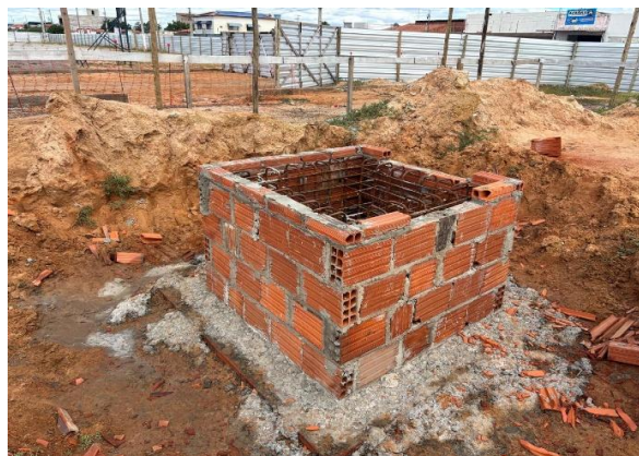
Foto 8: Execução de fôrma perdida em cálice de sapata de fundação
