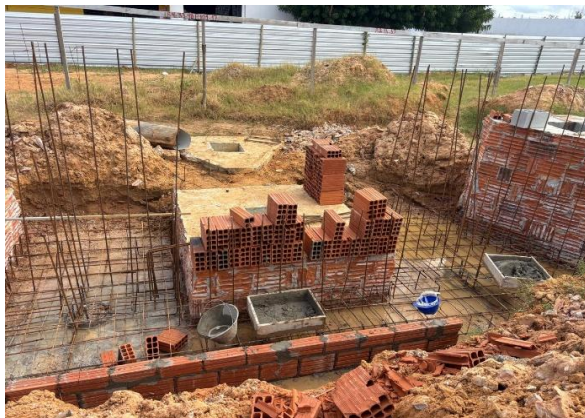
Foto 11: Execução de lastro de concreto magro - execução de estaca escavada de concreto para contenção - execução de fôrma para esteira de contenção
