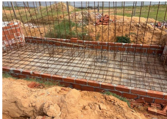
Foto 12: Execução de armadura para esteira de contenção
