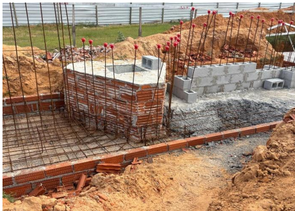
Foto 13: Execução de armadura para esteira de contenção - execução de parede de contenção estrutural
