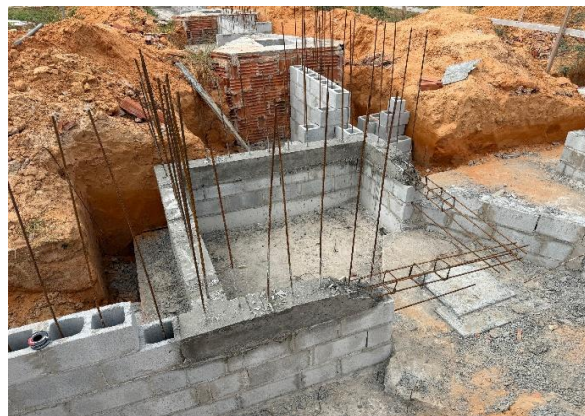
Foto 6: Execução de viga de concreto armado para poço de elevador
