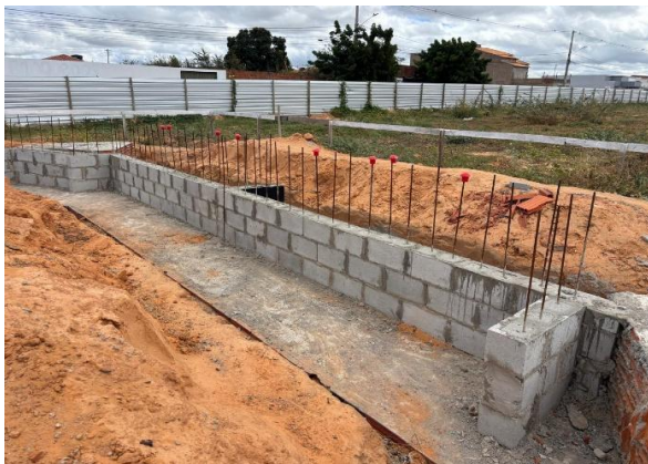
Foto 1: Execução de parede de contenção com bloco estrutural de cimento, etapa 1
