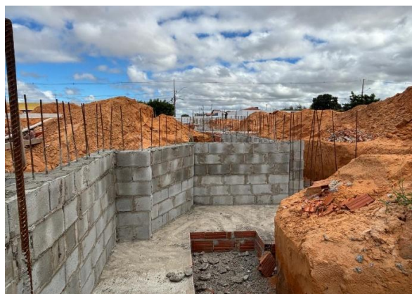
Foto 2: Execução de parede de contenção com bloco estrutural de cimento, etapa 1
