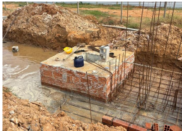
Foto 10: Execução de lastro de concreto magro - execução de estaca escavada de concreto para contenção
