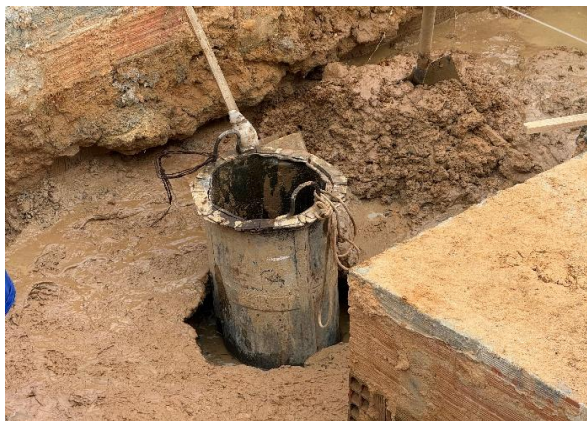
Foto 15: Execução de estaca escavada com concreto moldado em loco
