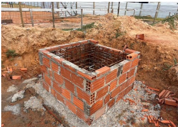
Foto 7: Execução de fôrma perdida em cálice de sapata de fundação
