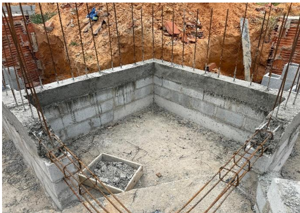
Foto 5: Execução de viga de concreto armado para poço de elevador
