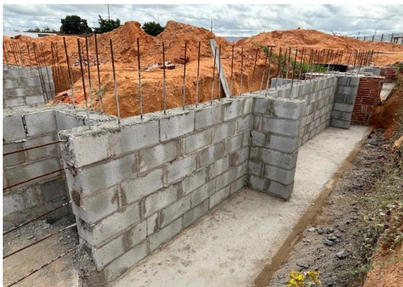
Foto 3: Execução de parede de contenção com bloco estrutural de cimento, etapa 1
