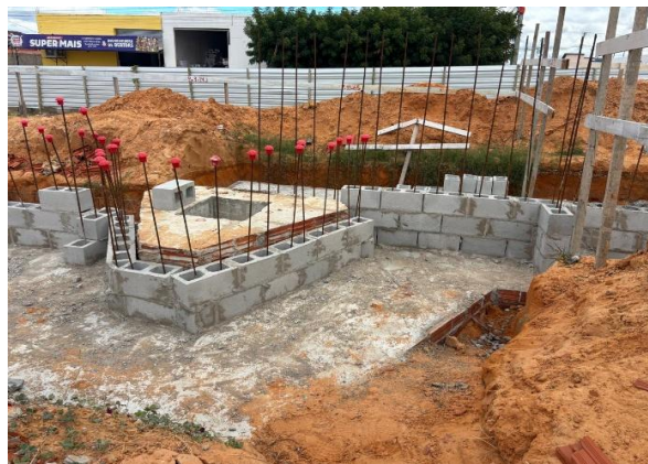
Foto 14: Execução de parede de contenção com bloco estrutural de cimento, etapa 1
