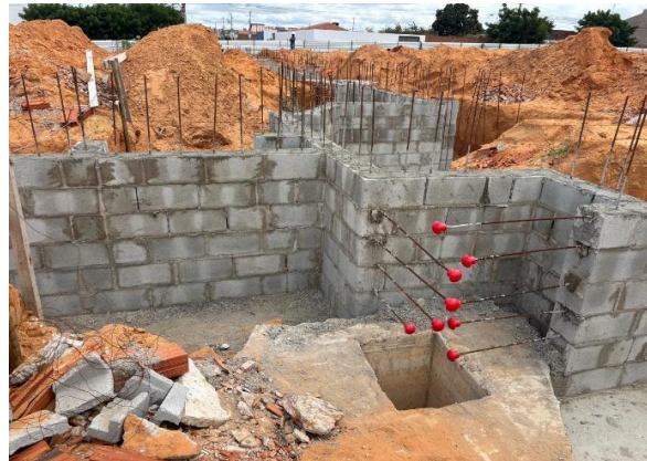
Foto 4: Execução de parede de contenção com bloco estrutural de cimento, etapa 1
