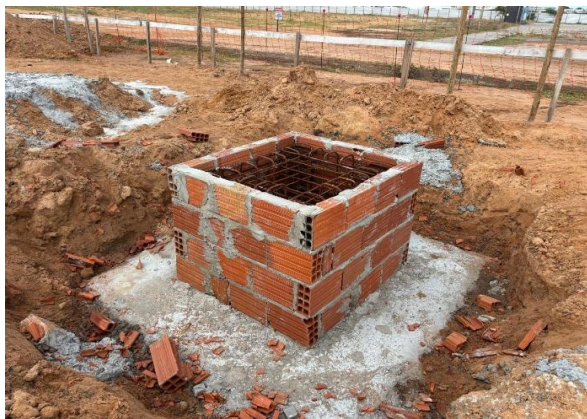
Foto 9: Execução de fôrma perdida em cálice de sapata de fundação
