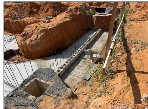
Foto 16: Execução de alvenaria estrutural
