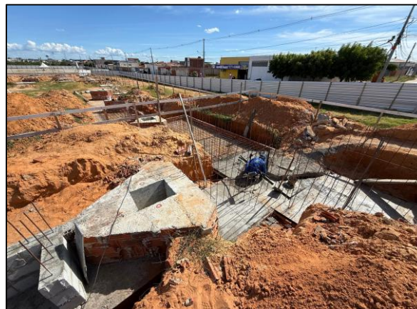
Foto 14: Execução de concretagem de sapata corrida etapa de contenções
