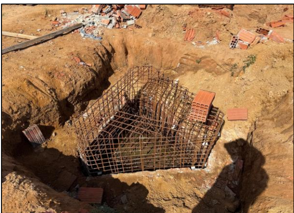
Foto 5: Execução de armadura de aço para bloco de coroamento
