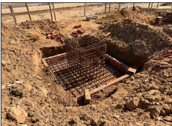
Foto 3: Execução de fôrma perdida sapata de fundação
