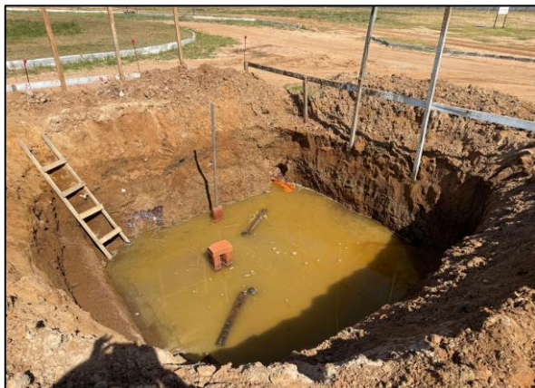
Foto 1: sapata escavada pronta para receber armadura de aço, notado presença de água do lençol freático
