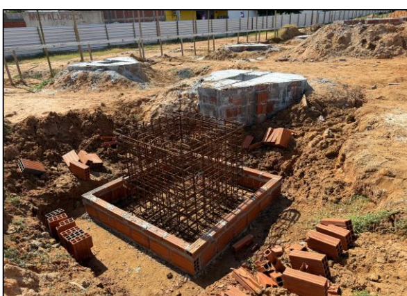
Foto 6: Execução de armadura de aço para bloco de coroamento
