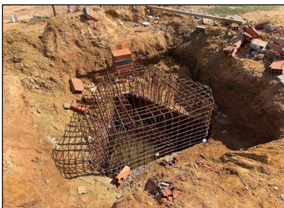
Foto 4: Execução de armadura de aço para bloco de coroamento
