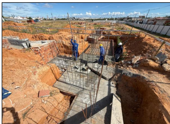
Foto 13: Execução de concretagem de sapata corrida etapa de contenções
