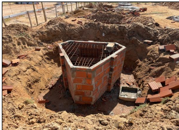
Foto 2: Execução de fôrma perdida bloco de coroamento
