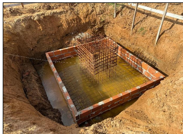
Foto 12: execução de forma perdida para base de sapata de fundação
