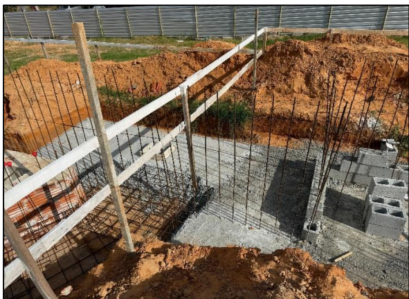
Foto 1: Concretagem de sapata corrida para contenção etapa 1
