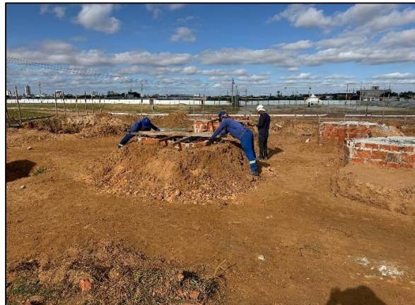
Foto 14: posicionamento de forma tipo cálice e reaterro manual
