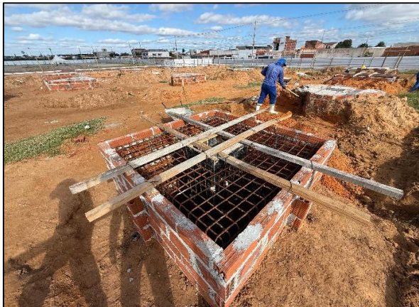
Foto 13: posicionamento de forma tipo cálice e reaterro manual
