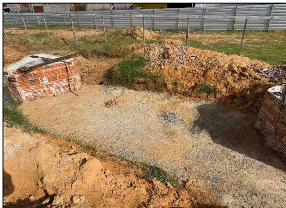
Foto 5: execução de concreto magro e estaca escavada para etapa de contenção
