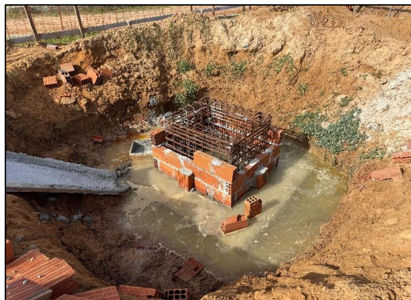
Foto 6: execução de forma perdida para sapata de fundação
