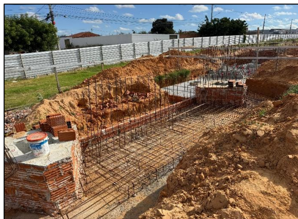
Foto 4: montagem de armadura para etapa de contenção
