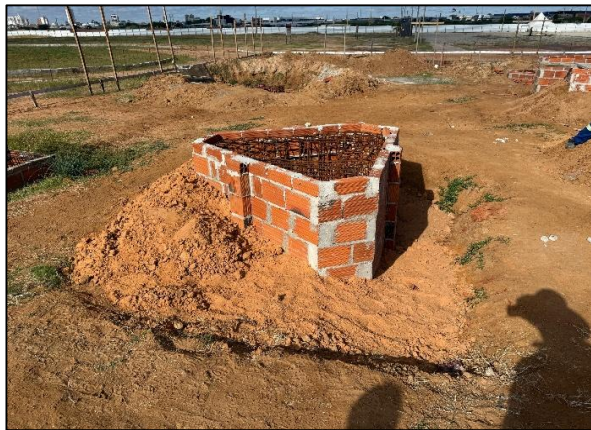
Foto 9: reaterro manual para bloco de coroamento
