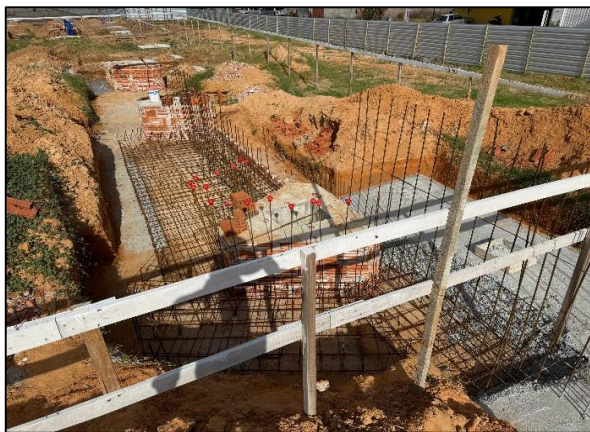
Foto 3: montagem de armadura para etapa de contenção
