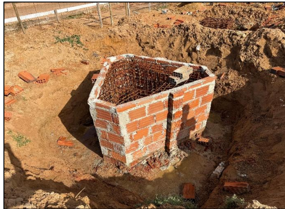
Foto 8: reaterro manual para bloco de coroamento
