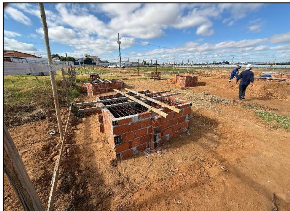
Foto 11: posicionamento de forma tipo cálice e reaterro manual
