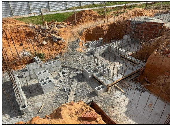
Foto 2: Concretagem de sapata corrida para contenção etapa 1
