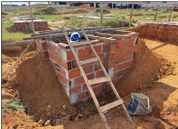
Foto 7: execução de forma perdida e posicionamento de forma tipo cálice
