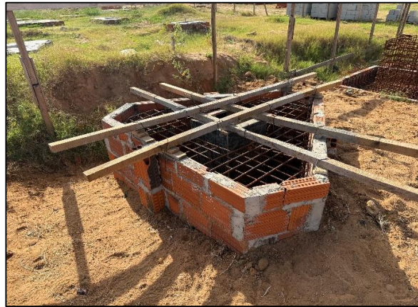
Foto 10: reaterro manual e posicionamento de forma tipo cálice
