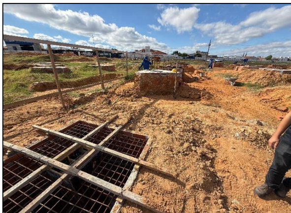
Foto 15: Execução de concretagem de sapata corrida etapa de contenções
