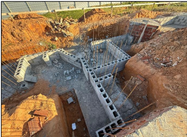
Foto 16: Etapa de contenção etapa 1
