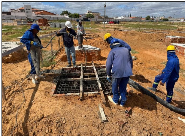
Foto 4: Execução de concretagem usinada de 11 blocos de coroamento e 6 bases de sapatas de fundação
