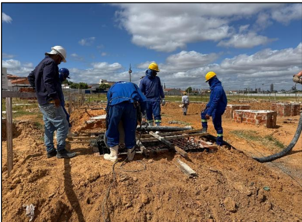
Foto 3: Execução de concretagem usinada de 11 blocos de coroamento e 6 bases de sapatas de fundação
