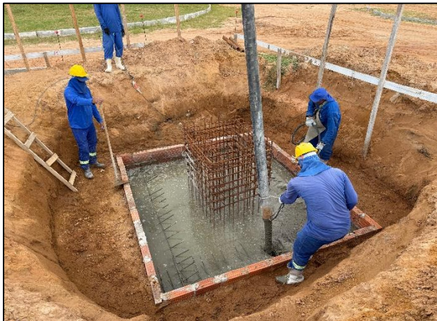
Foto 6: Execução de concretagem usinada de 11 blocos de coroamento e 6 bases de sapatas de fundação
