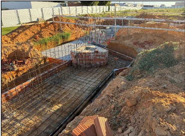
Foto 13: Etapa de contenção etapa 1
