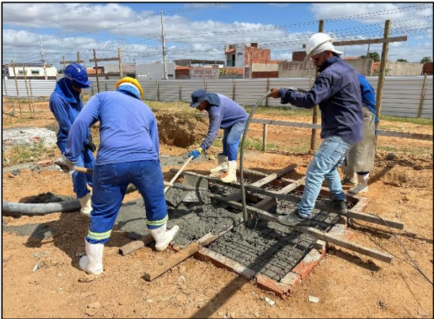
Foto 5: Execução de concretagem usinada de 11 blocos de coroamento e 6 bases de sapatas de fundação
