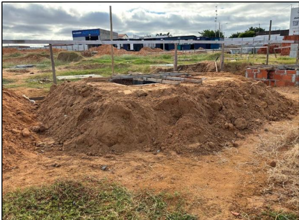
Foto 2: Reaterro lateral de bloco de coroamento para concretagem
