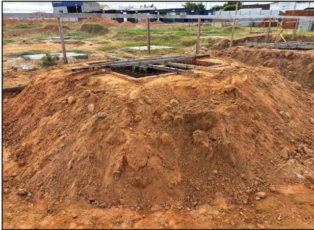
Foto 1: Reaterro lateral de bloco de coroamento para concretagem
