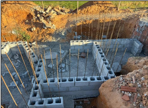
Foto 15: Etapa de contenção etapa 1
