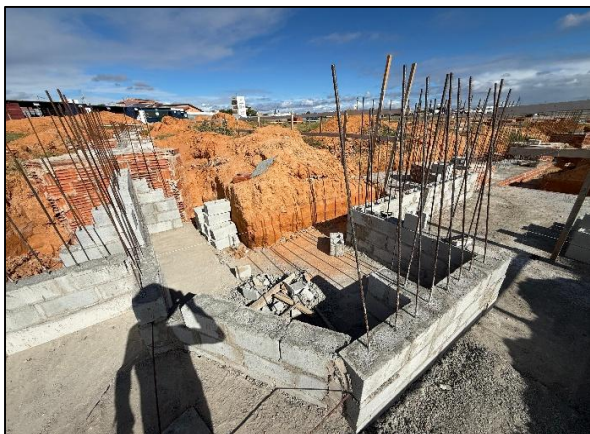
Foto 13: Execução de parede estrutural em etapa de contenção
