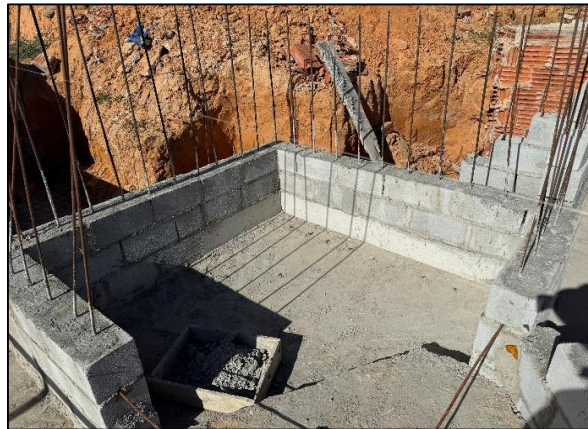
Foto 12: Execução de parede estrutural em etapa de contenção
