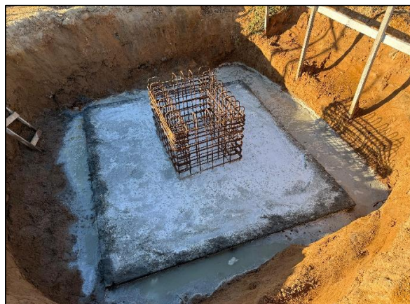
Foto 14: Base de sapata concretada
