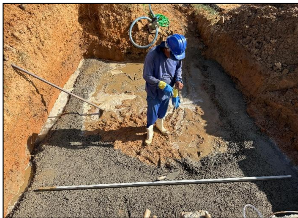
Foto 15: Execução de concreto magro em etapa de contenção
