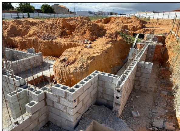
Foto 9: Execução de parede estrutural em etapa de contenção
