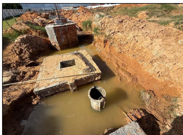
Foto 16: Presença de água do lençol freático
