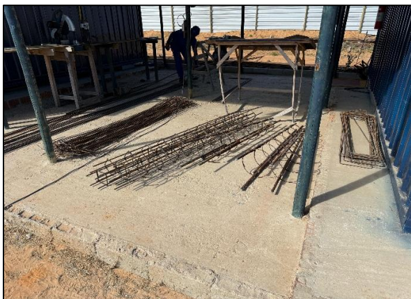
Foto 7: Corte, dobra e montagem de ferragem para etapa de contenção
