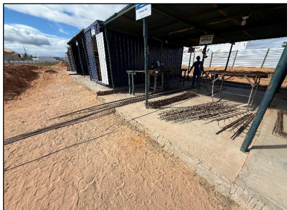
Foto 8: Corte, dobra e montagem de ferragem para etapa de contenção
