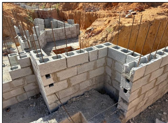
Foto 10: Execução de parede estrutural em etapa de contenção
