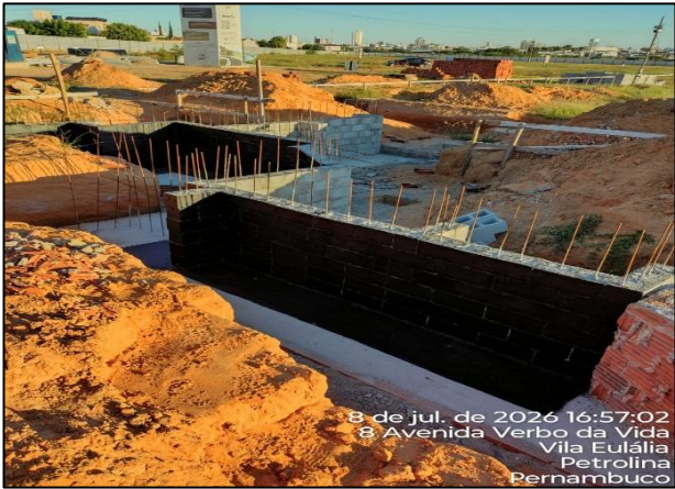
Foto 1: Execução de impermeabilização de parede de contenção da etapa 1
