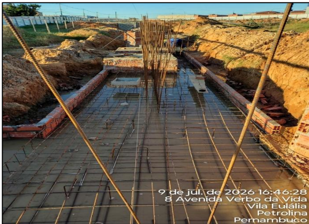
Foto 5: Execução de armadura de esteira de contenção etapa 2
