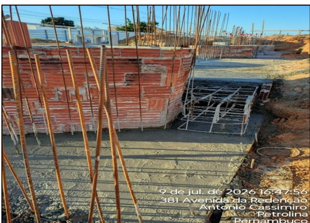
Foto 6: Execução de armadura de esteira de contenção etapa 2
