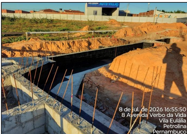
Foto 2: Execução de impermeabilização de parede de contenção da etapa 1
