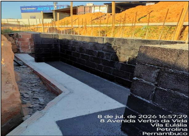
Foto 3: Execução de impermeabilização de parede de contenção da etapa 1
