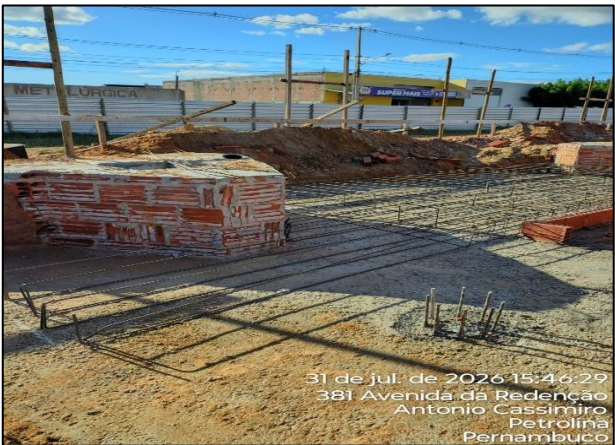
Foto 11: Execução de armadura para sapata corrida
