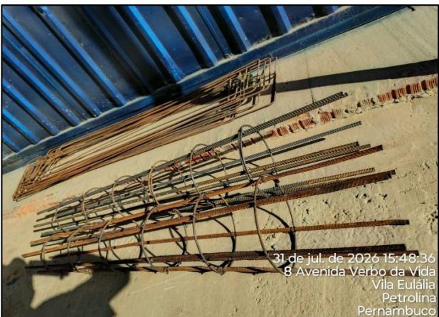
Foto 12: Execução de estaca escavada
