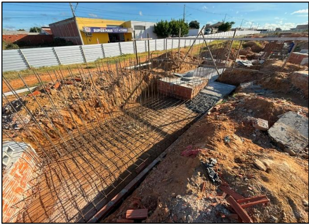
Foto 7: Execução de armadura
