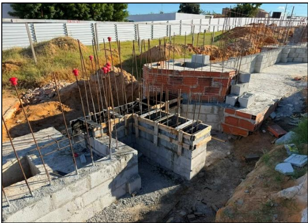
Foto 8: Execução de fôrma de madeira para cinta
