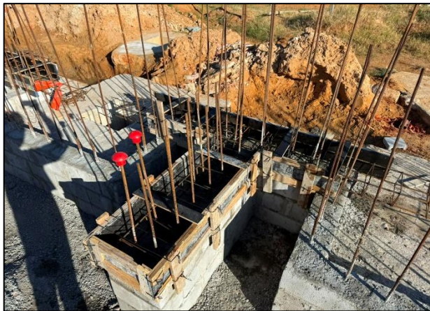
Foto 9: Execução de fôrma de madeira para cinta
