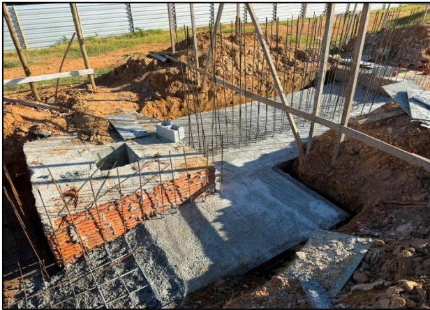
Foto 10: Execução de concretagem de sapata corrida
