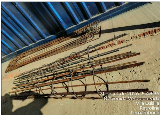
Foto 12: Execução de estaca escavada
