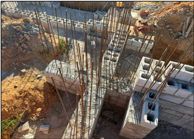
Foto 2: Execução de parede de contenção etapa 2. Parede dupla enrijessida, com concreto e aço.
