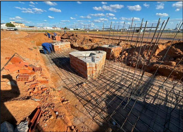
Foto 11: Montagem de armadura para sapata corrida
