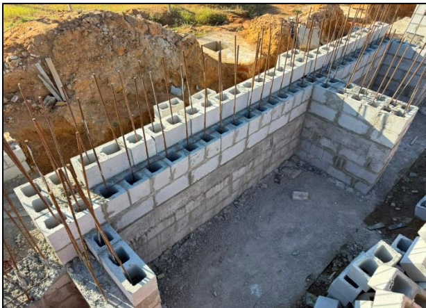
Foto 5: Execução de parede de contenção etapa 2. Parede dupla enrijessida, com concreto e aço.
