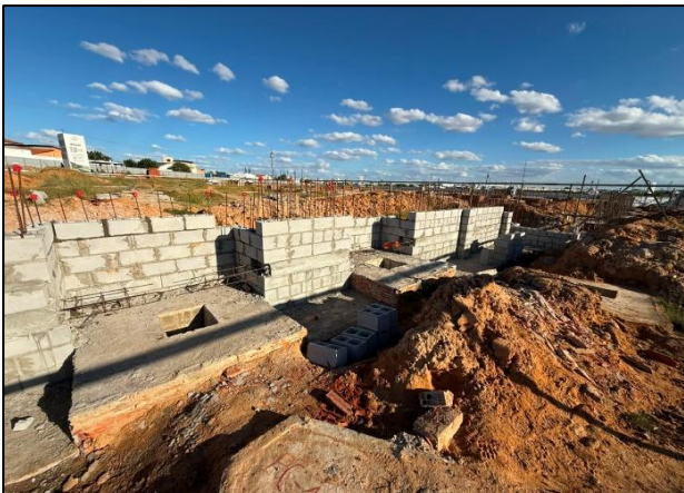
Foto 4: Execução de parede de contenção etapa 2. Parede dupla enrijessida, com concreto e aço.
