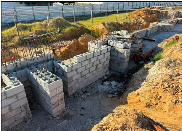
Foto 3: Execução de parede de contenção etapa 2. Parede dupla enrijessida, com concreto e aço.
