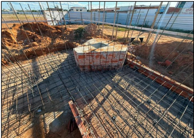
Foto 10: Montagem de armadura para sapata corrida
