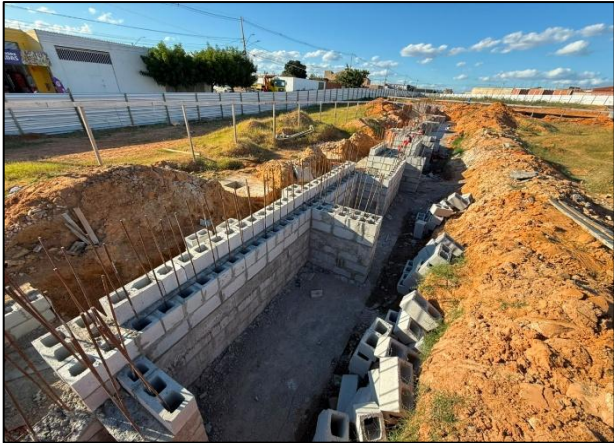
Foto 1: Execução de parede de contenção etapa 2. Parede dupla enrijessida, com concreto e aço.
