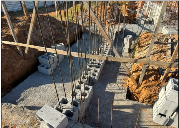
Foto 8: Execução de parede de contenção etapa 2. Parede dupla enrijecida, com concreto e aço.
