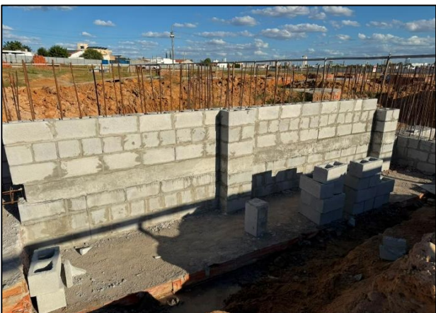
Foto 6: Execução de parede de contenção etapa 2. Parede dupla enrijessida, com concreto e aço.
