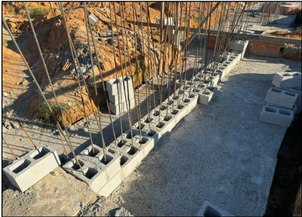
Foto 7: Execução de parede de contenção etapa 2. Parede dupla enrijecida, com concreto e aço.
