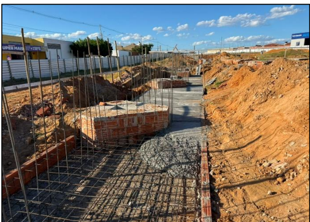
Foto 12: Montagem de armadura para sapata corrida
