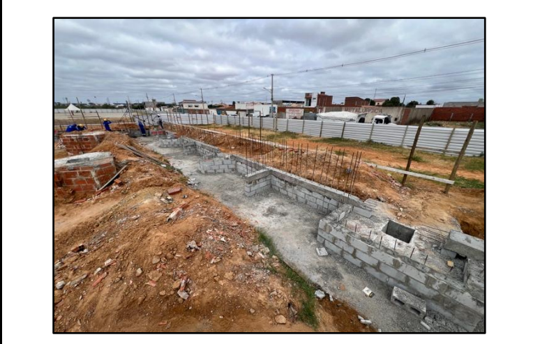
Foto 13: Vista geral de contenções etapa 3
