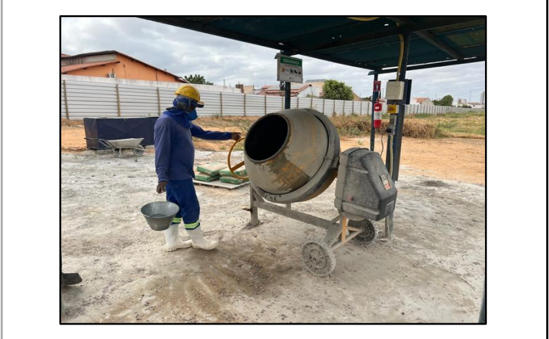
Foto 16: Execução de produções de concreto para etapa de contenção
