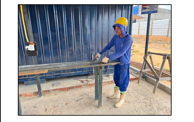
Foto 15: Execução de corte e dobra de aço
