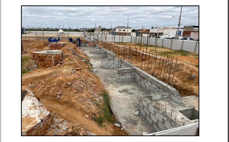
Foto 14: Vista geral de contenções etapa 3
