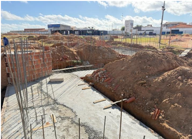
Foto 6: Andamento de concreto magro na sapata corrida, etapa 3.
