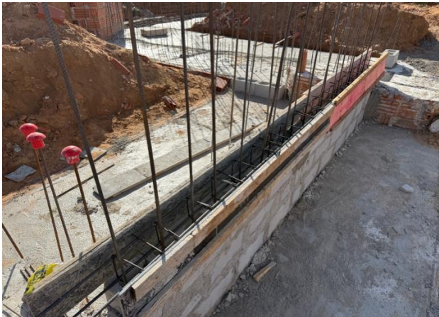
Foto 3: Andamento de parede de contenção etapa 2. Parede dupla enrijecida, com concreto e aço.
