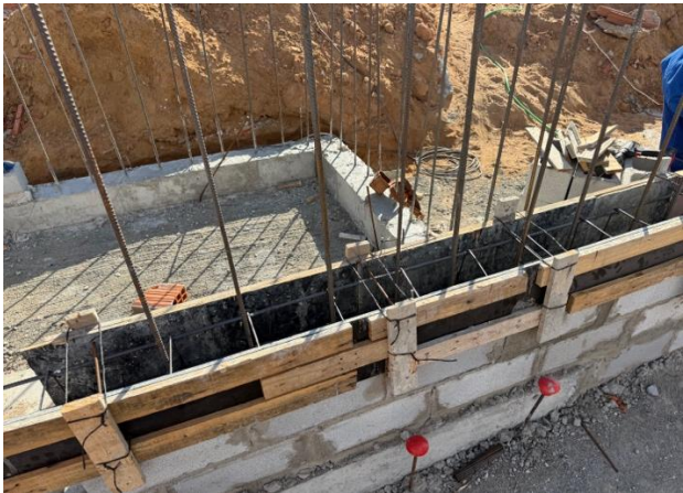
Foto 4: Andamento de parede de contenção etapa 2. Parede dupla enrijecida, com concreto e aço.
