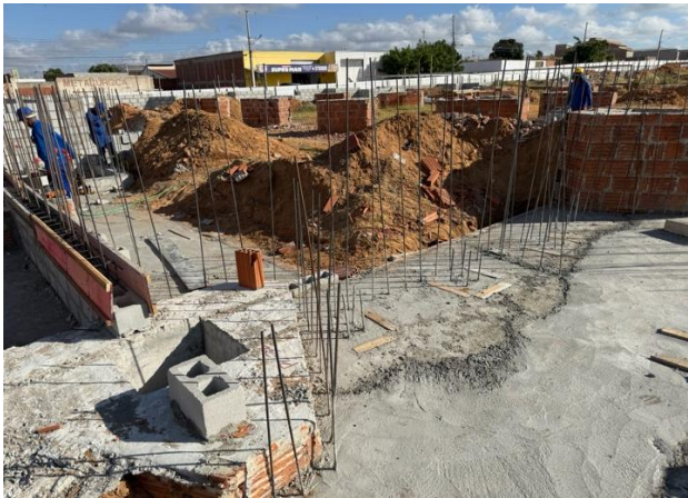
Foto 5: Andamento de concreto magro na sapata corrida, etapa 3.
