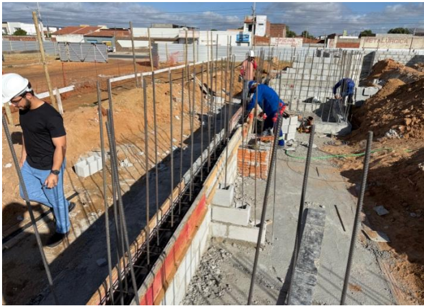
Foto 2: Andamento de parede de contenção etapa 2. Parede dupla enrijecida, com concreto e aço.
