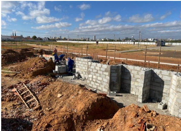
Foto 1: Andamento de parede de contenção etapa 2. Parede dupla enrijecida, com concreto e aço.
