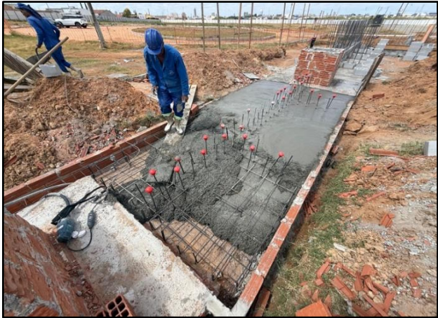
Foto 15: Execução de concretagem de esteira corrida com concreto moldado em obra, etapa 3.
