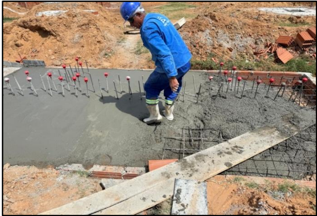
Foto 13: Execução de concretagem de esteira corrida com concreto moldado em obra, etapa 3.
