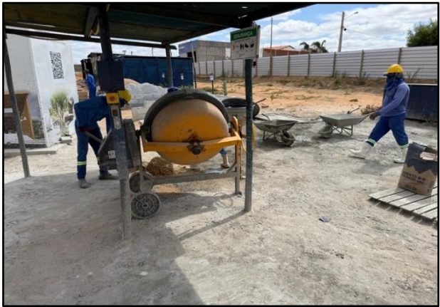
Foto 16: Moldagem de concreto em betoneira
