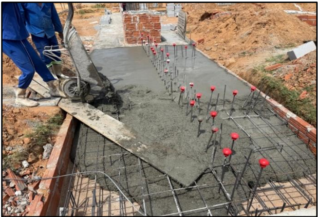
Execução de concretagem de esteira corrida com concreto moldado em obra, etapa 3.
